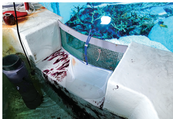
水面の汚れの吸い込み口。浮かんた卵も集まるのでネットで回収できる
