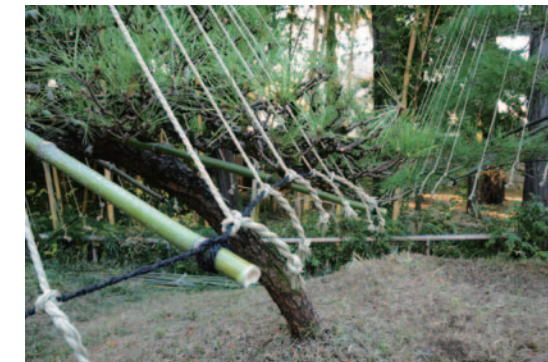
しゆるなわ しゆるなわ 「バチ」に棕櫚縄を結束し棕櫚縄に吊縄を結束します
