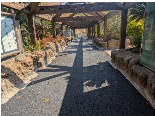
防水工事と併せて舗装補修を実施(上野)
