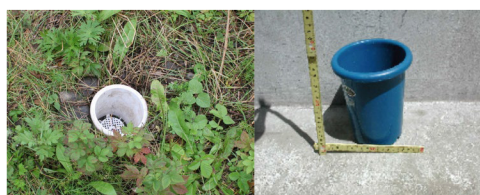
墜落函のサイズと設置状況
